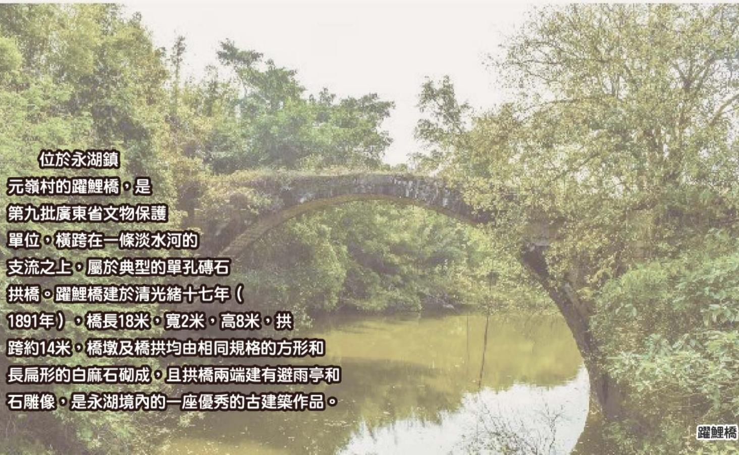
位於永湖鎮元嶺村的躍鯉橋，是第九批廣東省文物保護單位，橫跨在一條淡水河的支流之上，屬於典型的單孔磚石拱橋。躍鯉橋建於清光緒十七年（1891年），橋長18米，寬2米，高8米，拱跨約14米，橋墩及橋拱均由相同規格的方形和長扁形的白麻石砌成，且拱橋兩端建有避雨亭和石雕像，是永湖境內的一座優秀的古建築作品。
